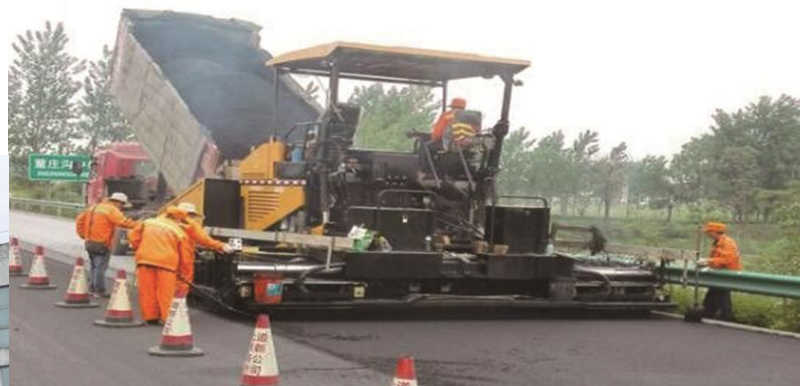
橡胶沥青加铺工程
