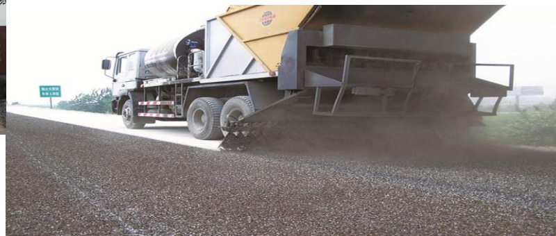
同步碎石封层工程
