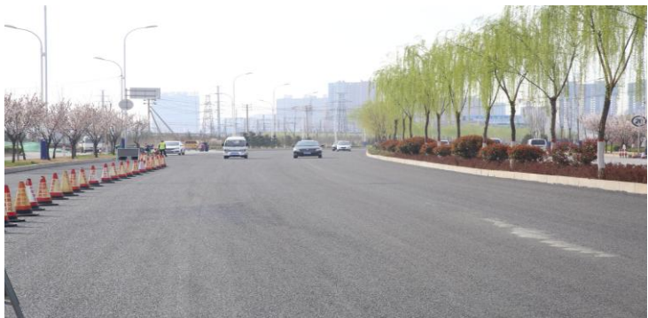
精细抗滑磨耗层工程
