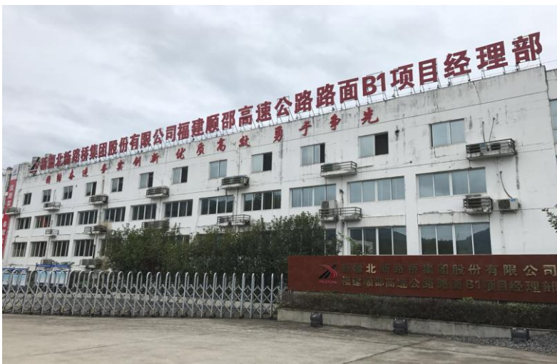
福建顺邵高速公路路面建设工程
